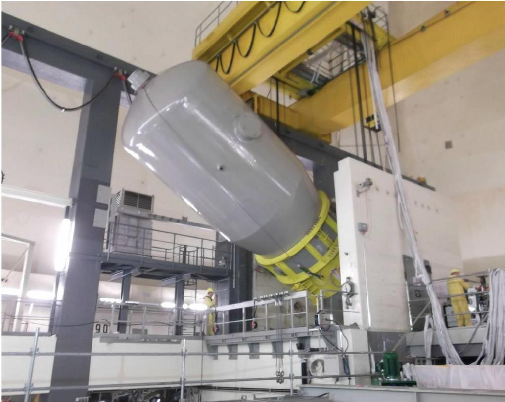
**Abbau des Dampferzeugers im Kernkraftwerk Obrigheim im Rahmen der 2. SAG**
